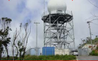
Cバンド偏波ドップラー実験レーダー (クライストロン、TWTA)
